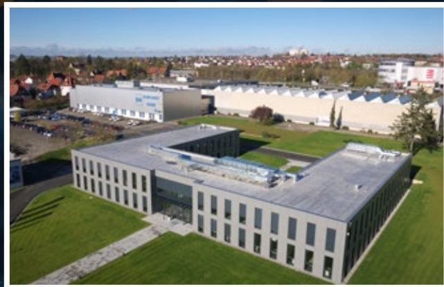
Reutlingen – Hauptverwaltung und Fertigungshallen.
